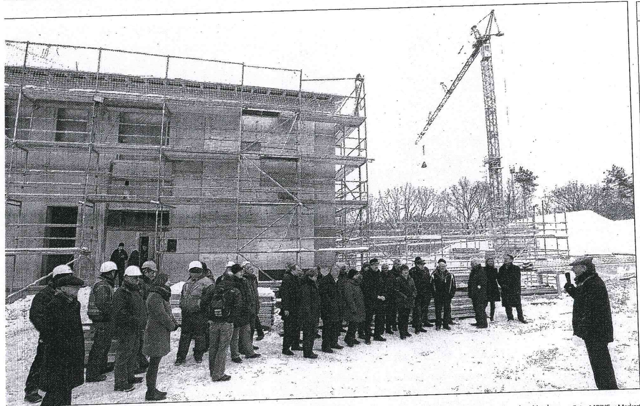
errunde im Schneegestöber: WSE-Verbandsvorsteher Henner Haferkorn (r.) begrüßt die Richtfest-Gäste. Der Kran schwenkt die Krone über den Neubau. Foto: MOZ/Ger Markt
