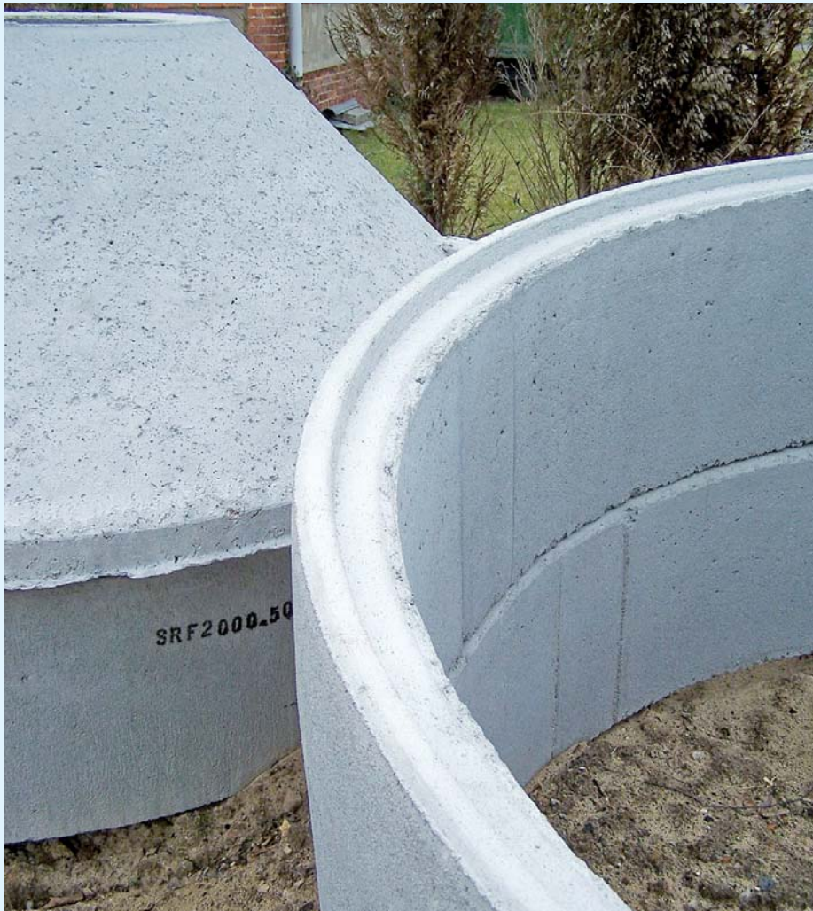
BETONSCHACHTBEHÄLTER: in Ringbauweise mit Fugen nach DIN 4034, Teil 2 Abwassersammelgruben nicht mehr zulässig
