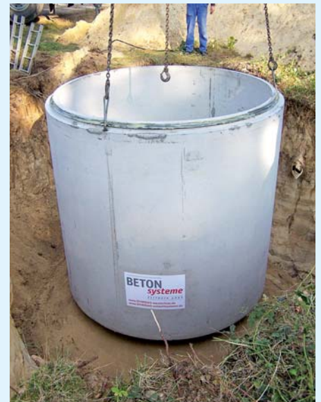
BETONBEHÄLTER: Diese Ausführung wird den Anforderungen der DIN 1986-100:2008-05 für Abwassersammelgruben gerecht.
