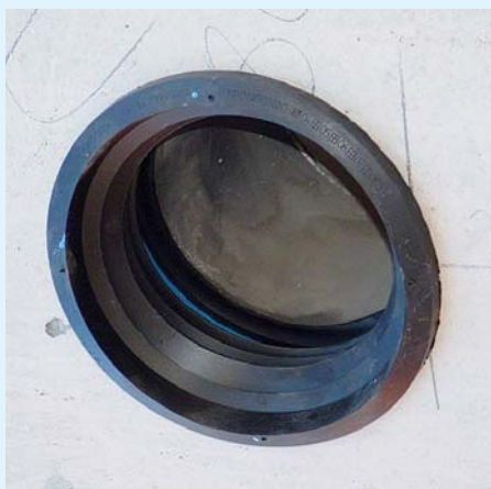
ROHREINFÜHRUNG: Bild 4 einer Abwassersammelgrube aus Beton als Kernbohrung mit Mehrfachlippendichtung
