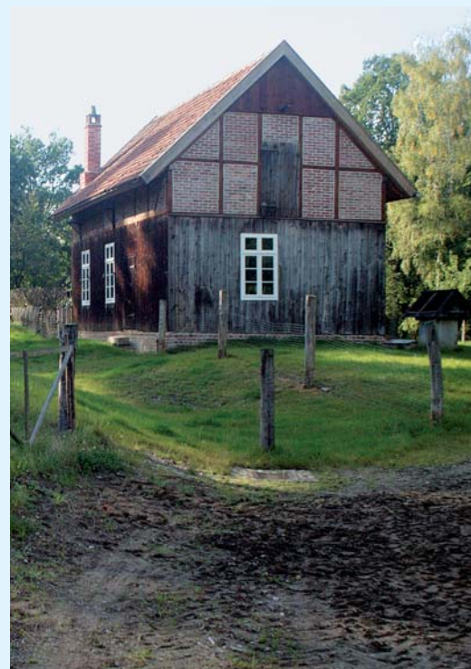
NUN SINNVOLL GEREGLT: Bild 6 Abwassersammelgruben sind für den ländlichen Raum unentbehrlich
